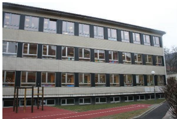
Die alten Fassaden werden durch die Anbringung von 20 cm Wärmedämmung und durch den Tausch der Fenster energie-technisch massiv aufgewertet.
