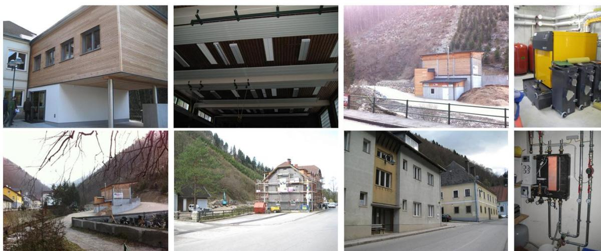
Fotos v.l.n.r. Oben: neuer Musikheimzubau zur Volksschule, neue Deckenstrahlheizung in der Mehrzweckhalle, Standort der Heizzentrale am ehem. Pfarrgrund neben der Jeßnitz; modernste Kesseltechnik 2 x 135 kW; Unten: Standortkonzept verbindet Synergien mit Zufahrt zum Friedhof; WET Wohnhaus wurde im Zuge der Heizungs-Umstellung thermisch saniert; Gemeindefürsorgehaus und Amtsgebäude folgen noch 2014; Nahwärme aus Holz bietet höchsten Heizkomfort mit neuester Technik der Wärme-Übergabestationen
