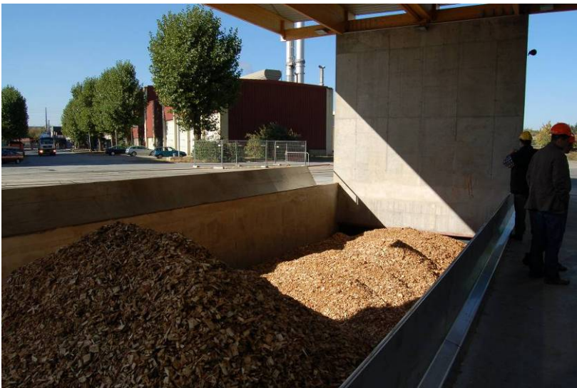
Abbildung 55: Überdachte Lagerung von Waldhackgut
